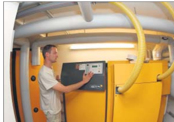
Nicht nur Sanierungsmaßnahmen, sondern auch neue Technik soll den Energieverbrauch senken. Hier präsentiert Hausmeister Oliver Katz die neue Pellet-Heizung in der Stadtbücherei.
